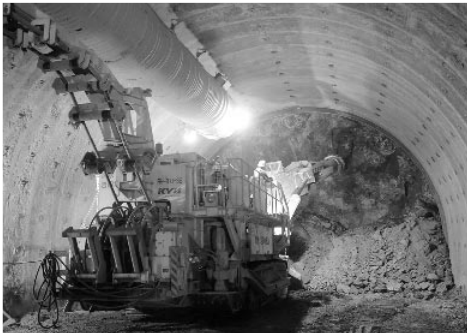
写真は全断面掘削状況
