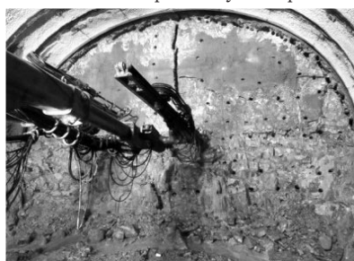
写真は連続孔・割岩孔削孔状況
